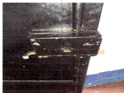
Foto 6: sustrucción de chapas
