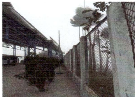
Foto 4 sustrucción de soporte o pescante de canal
