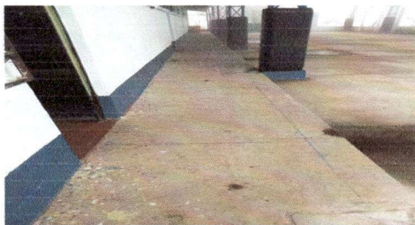
Foto 3 sustrucción de piso de torta de concreto por ceramico
